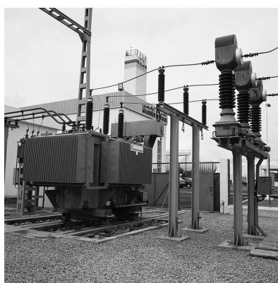
Fig. B23 : Transformateur respirant avec conservateur
