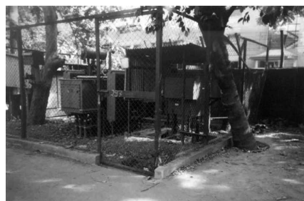
Fig. B34 : Poste d'extérieur sans enveloppe
